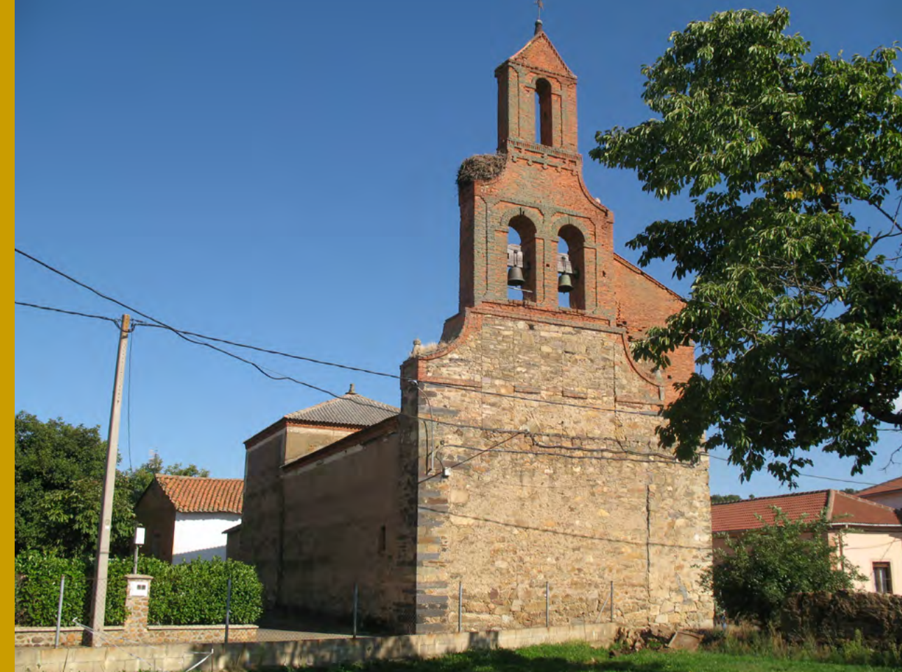
Iglesia de Villamejil. En la torre se detectan todos los recrecimientos de la misma, desde el siglo XVII, recogidos en los libros de fábrica de la Parroquia
