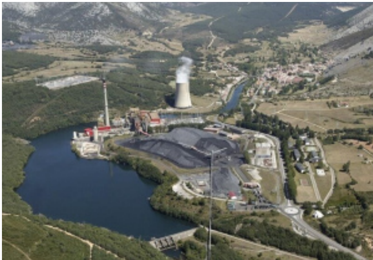
Central Térmica de Velilla del Río Carrión
