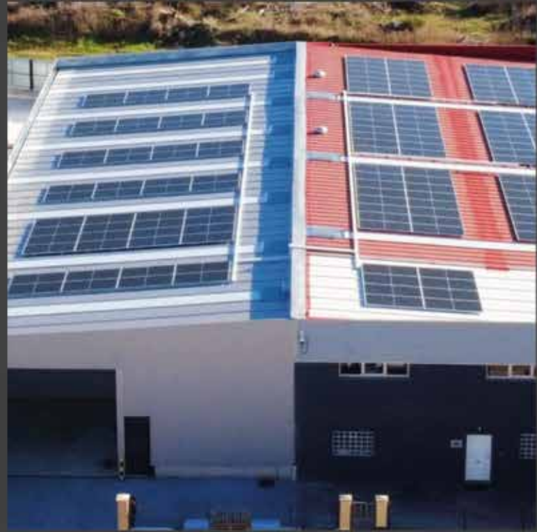
INSTALACION DE AUTOCONSUMO
