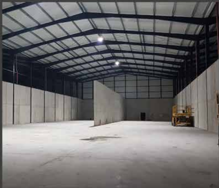
CONSTRUCCION DE NAVES INDUSTRIALES
