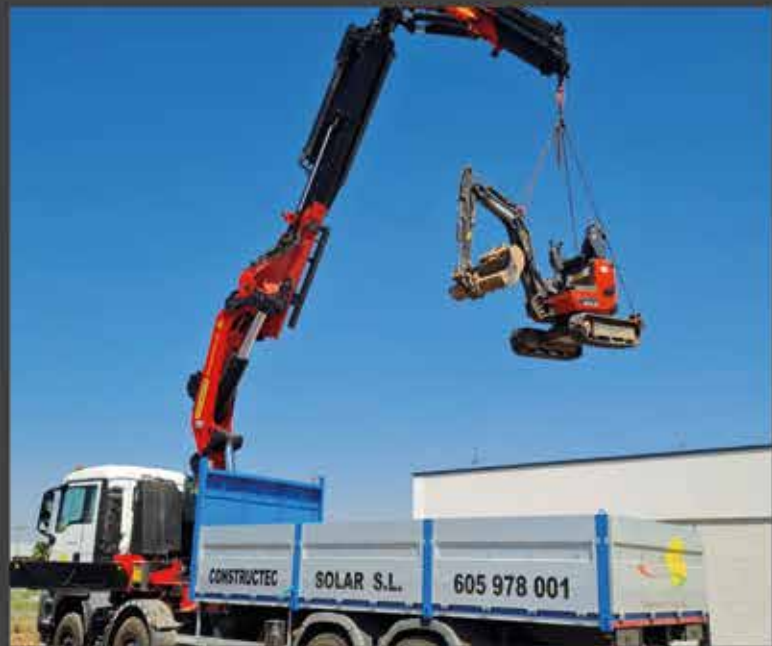
TRABAJOS CON GRUA
