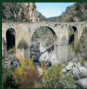
PUENTE DE LOS FRANCESES
